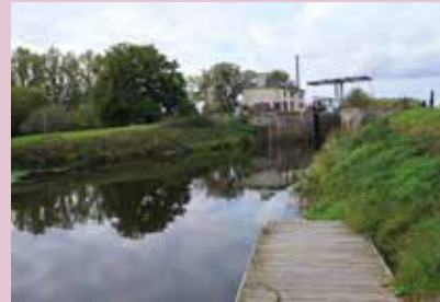
Écluse de Cicé. À 7 km de Pont-Réan
