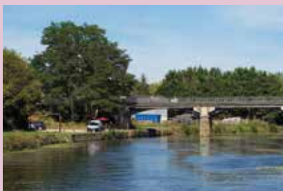
Pont de Bourg-des-Comptes, à 1,5 km de La Courbe
