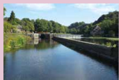
Écluse du Boël. à 8 km de La Courbe, tél. 06 38 82 88 89
