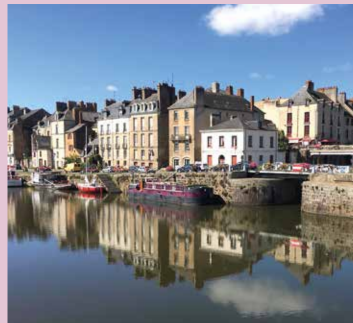
L'écluse d'Oust et le quai Duguay-Trouin, les demeures cossues des armateurs. Dans la rue derrière, on peut repérer les greniers à sel qui ont fait leur richesse.
