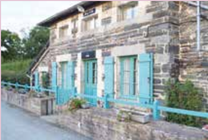
Maison éclusière de Mons, à 4 km de Pont-Réan
