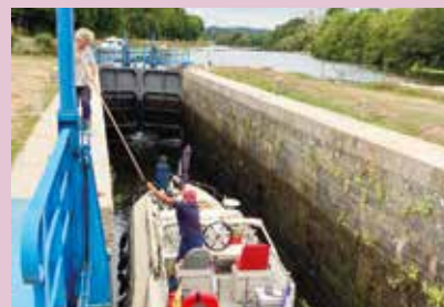
Écluse de Mâlon n°13, hauteur de chute importante, tél. 06 47 71 12 27
