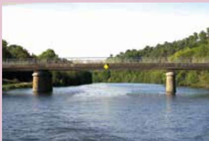
Pont de Saint-Malo-de-Phily
