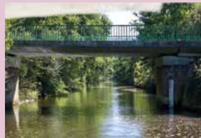
Tirant d'air 3 m 30. En période de crue surveiller la règle graduée
