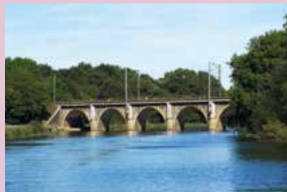
Pont Rail de Cambré
