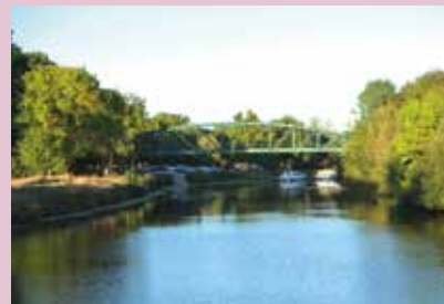
Pont et halte du Grand Pas à 5 km de Redon. Joli quai de pierre
