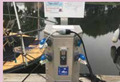
Borne multifonction du ponton
