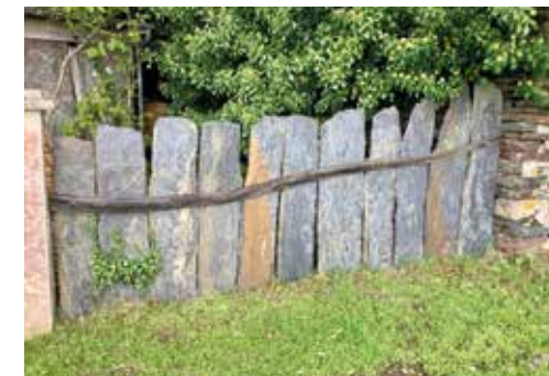
Pour séparer les propriétés, on utilise encore de grandes plaques de schistes.
