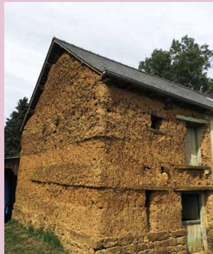
Maison traditionnelle du bassin de Rennes : une construction en terre crue et paille, appelée bauge. À la différence du torchis ou du pisé, la bauge n'utilise ni ossature bois ni coffrage. Le confort thermique de ce type de maison est remarquable. La plupart des maisons ont une assise en pierre.
