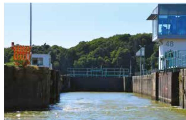
En attendant l'ouverture des portes, il est possible de se stationner le long du bajoyer bâbord en remontant la rivière où des pendilles permettent de s'amarrer de façon temporaire. Le même système est prévu sur le bajoyer tribord lorsque l'on désire écluser de l'amont vers l'aval.
